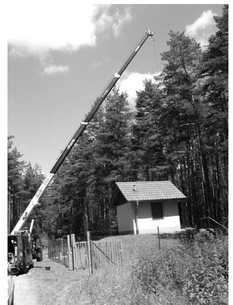
Unser Bild zeigt das Abheben des Brunnendeckels, der sich in einem Schacht vor dem Betriebsgebäude befindet mittels eines Autokrans.
