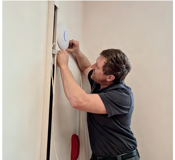
Hausmeister Tobias Schatz installiert einen W-Lan Hotspot
