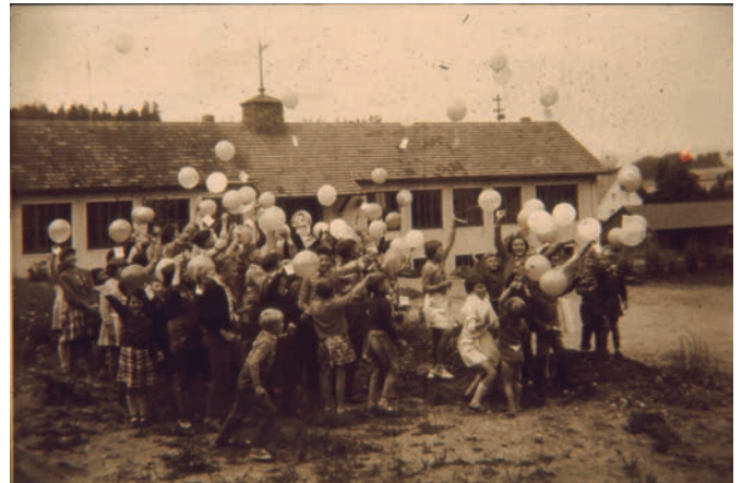
Luftballonsteigen vor dem Schulhaus in Gmünd
