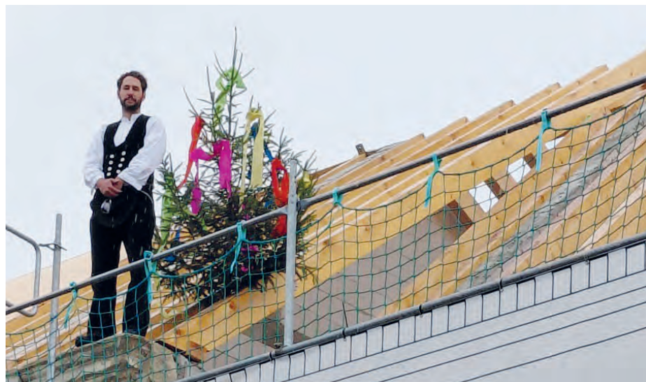
Hoch hinaus: Beim Richtspruch ließ Dachdecker Michael Kohl das Grafenwöhrer Verwaltungsgebäude „Dreifach Hochleben“.
